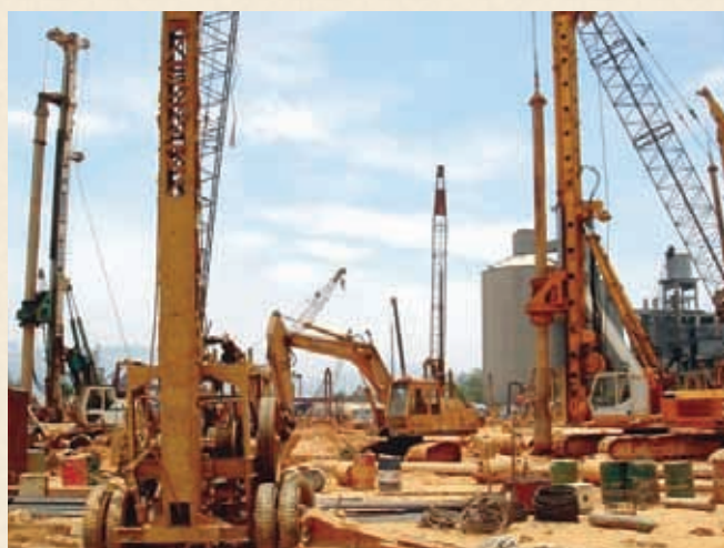
Khoan cọc nhồi nhà máy xi măng Hoàng Thạch dây chuyền III năm 2007
