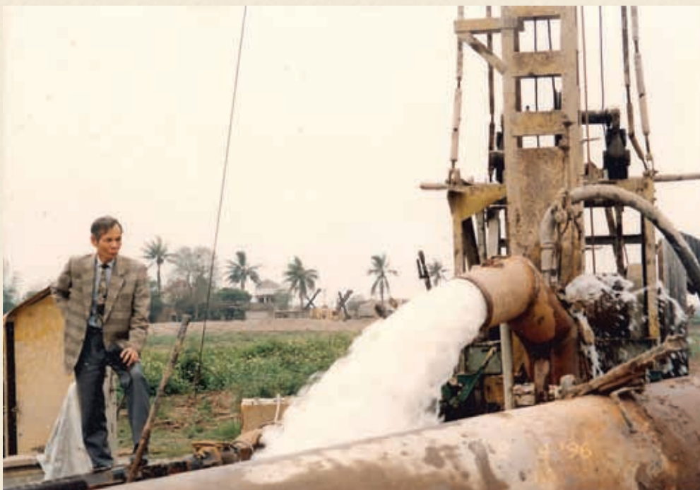
TGĐ Nguyễn Mạnh Hà kiểm tra công trình cấp nước Gia Lâm năm 1996
