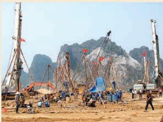
Khoan kiểm tra các tơ tại công trình xi măng Cẩm Phả năm 2006
