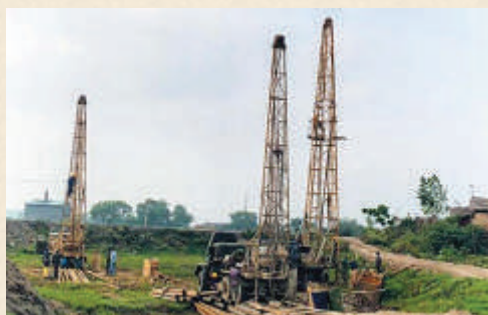
Dự án nước Thượng Cát năm 2004
